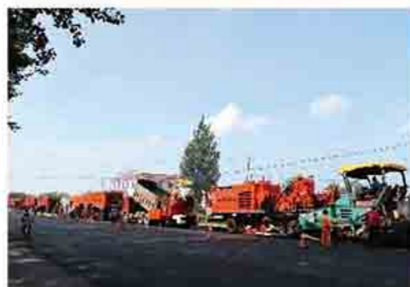
无扬尘、低排放, 英达热再生“无霾”施工
