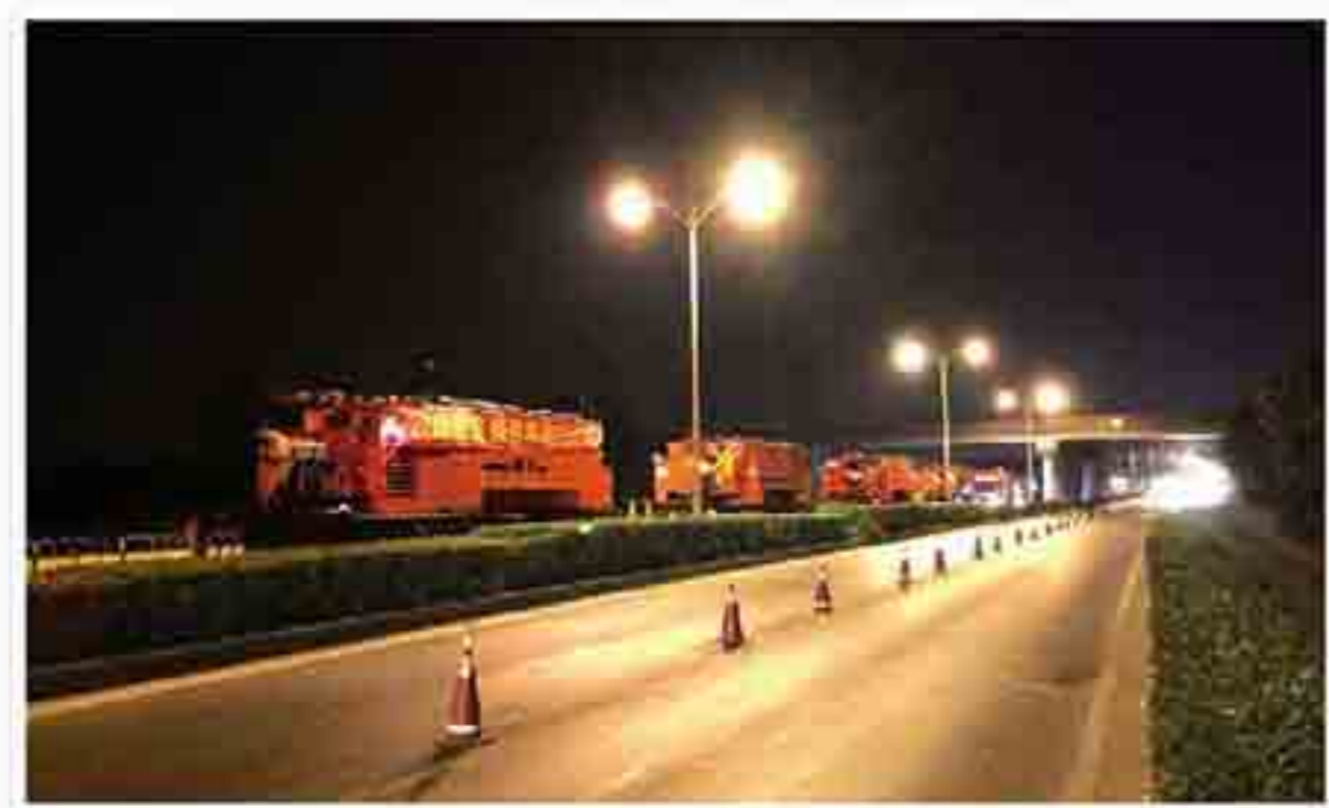
路面材料100%原价值循环再用，为国检加分
