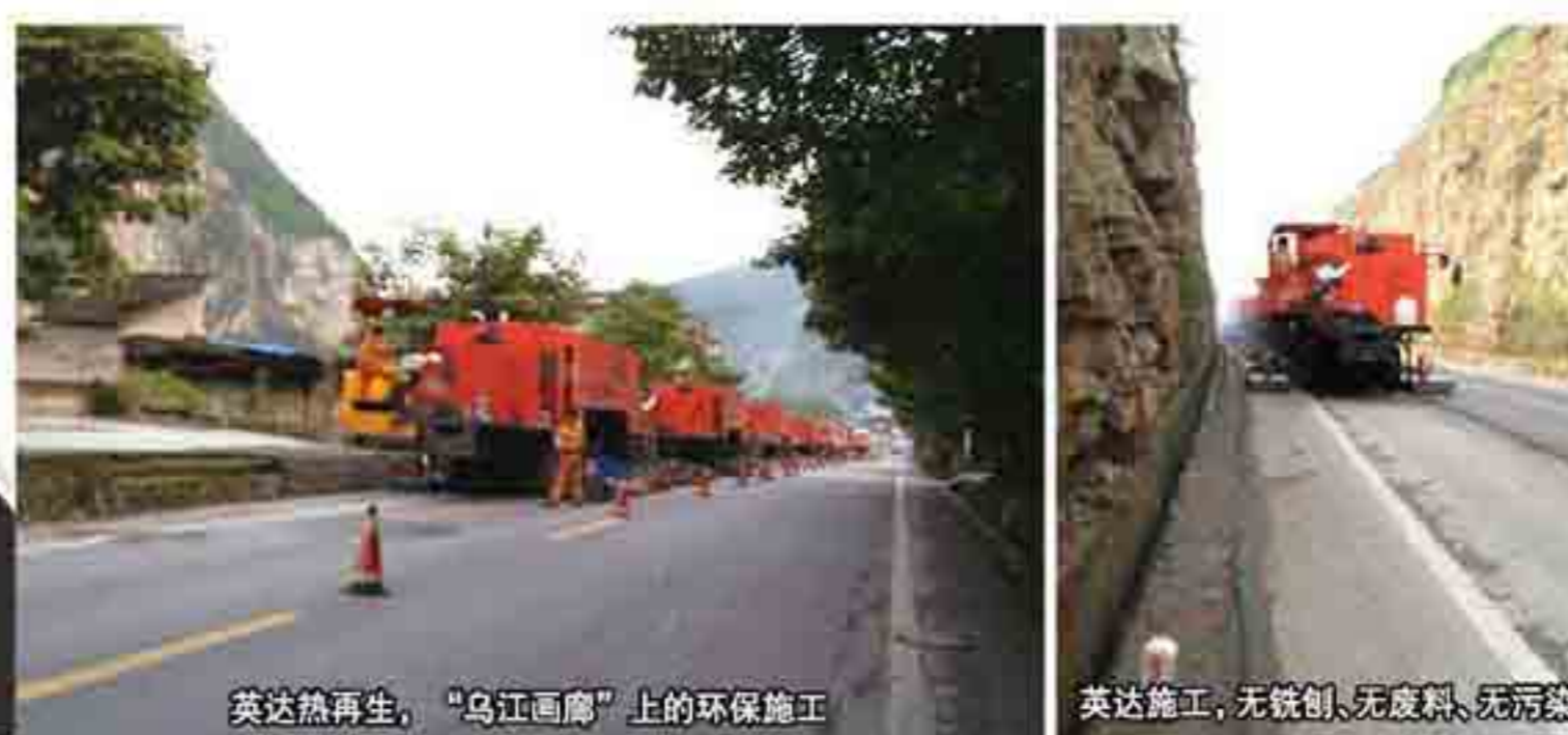
英达热再生，“乌江画廊”上的环保施工
