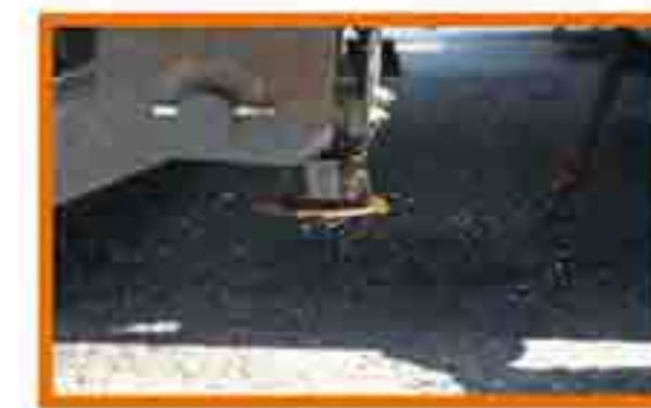
英达盘式热沥青洒布系统, 可以保证热沥青均匀洒布
