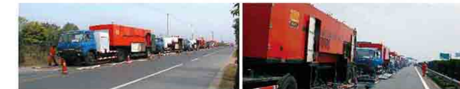
2006年英达滦平高速热再生施工
