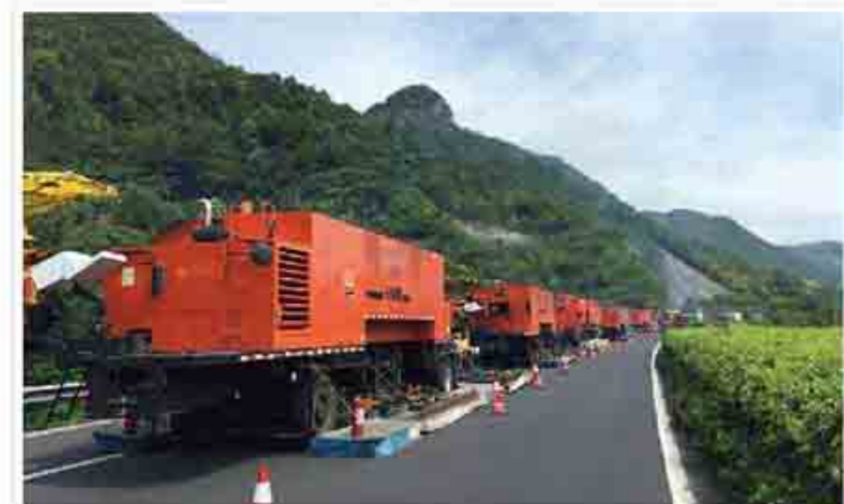
英达施工两股车道间为纵向热接缝，抗剪切力性能优秀
