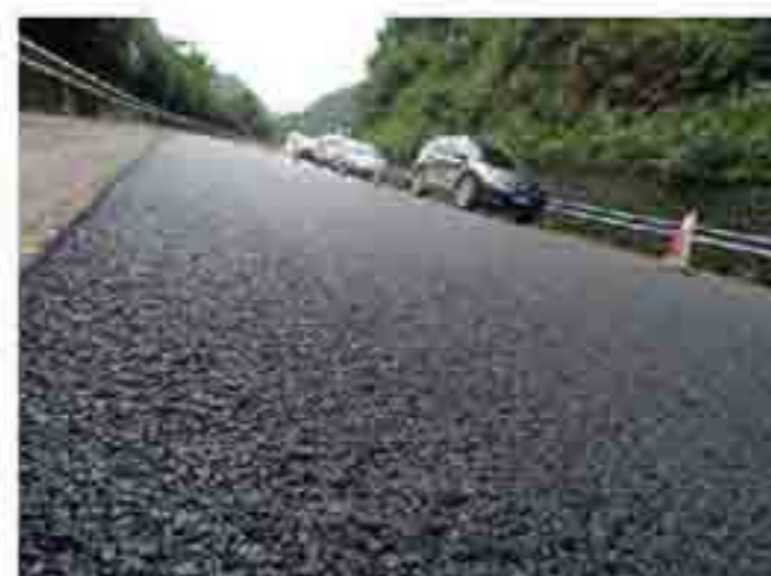
贵毕线G321施工后路面
