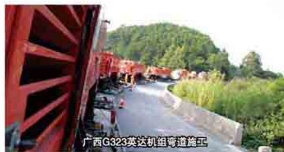
广西G323英达机组弯道施工
