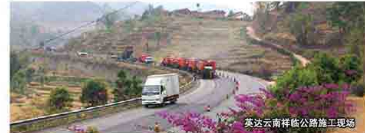
英达云南祥临公路施工现场
