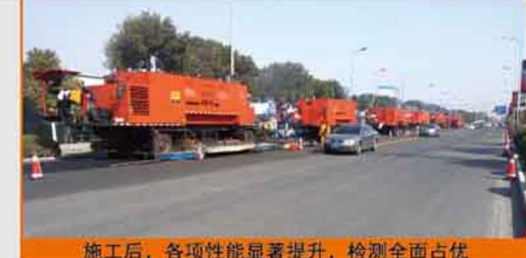
施工后，各项性能显著提升，检测全面占优
