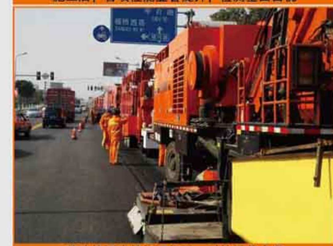
英达热再生精细调级配，对抗重载交通
