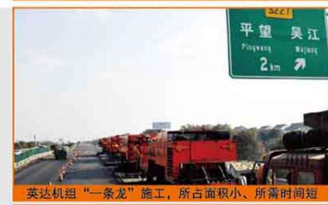
英达热再生精细调级配，对抗重载交通
