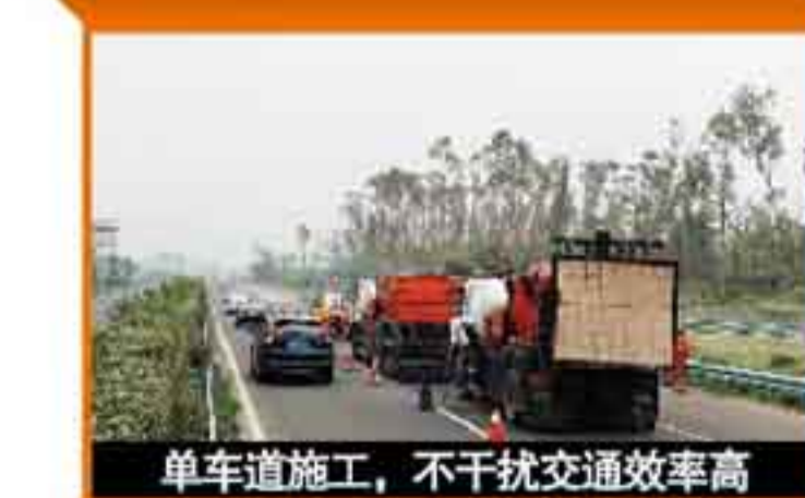
单车道施工，不干扰交通效率高
