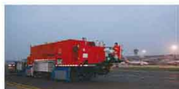
英达长沙国际机场滑行道施工现场
