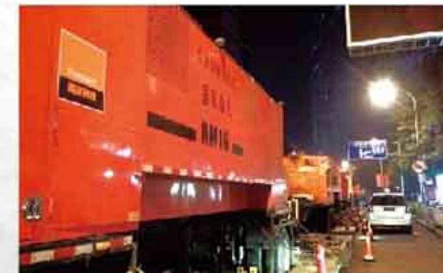
高效不封路，英达机组满足城市道路施工要求
