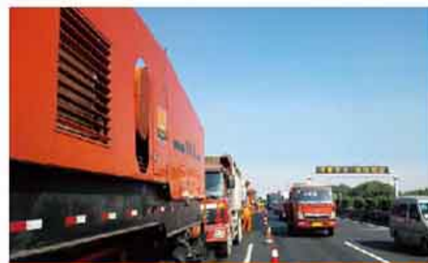
英达机组单车道施工，轻松应对苏嘉杭超车道
