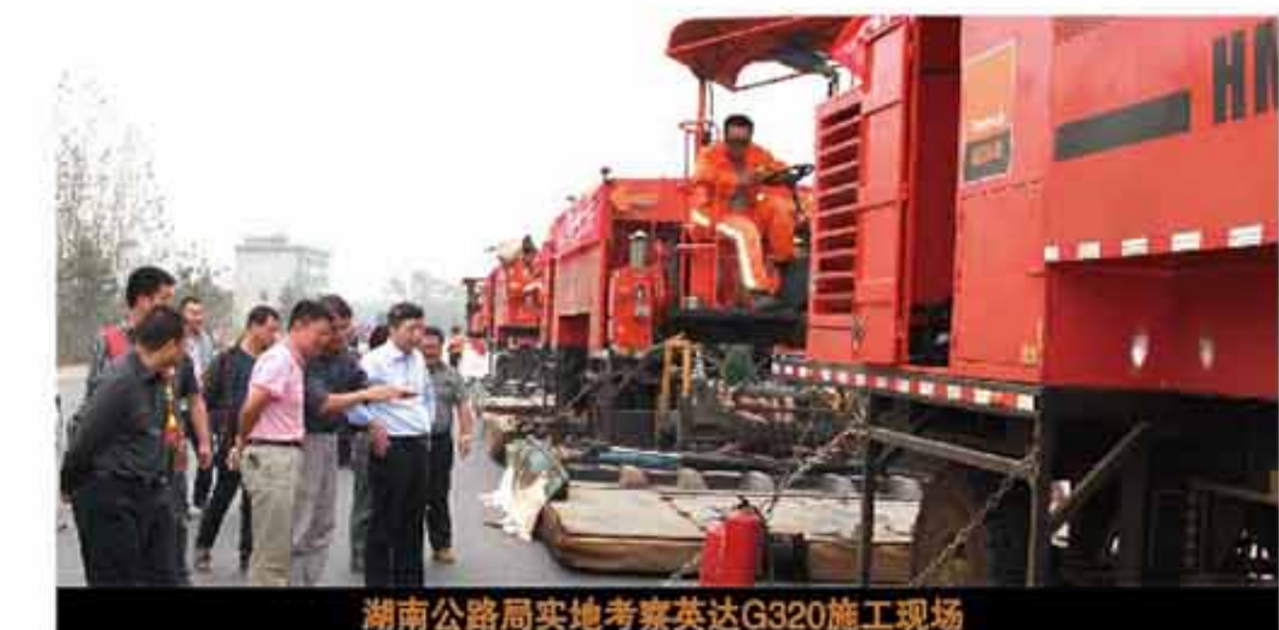
湖南公路局实地考察英达G320施工现场
