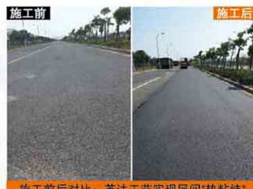
施工前后对比：英达工艺实现层间“热粘结”
