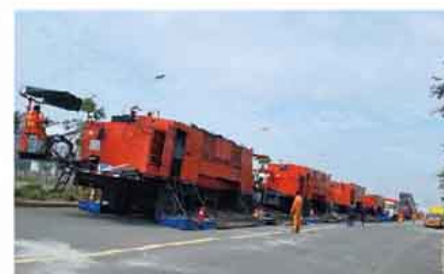
温岭松航中路应用环保节约的英达就地热再生技术
