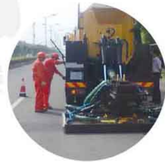
英达PM390，轻松应对各类路面裂缝
