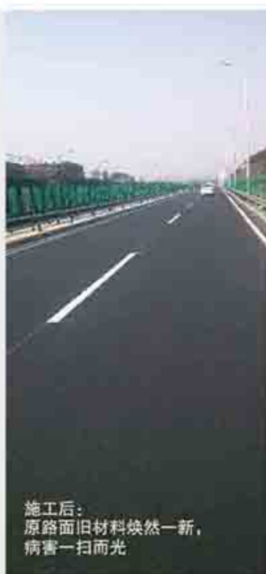
经现场检测，5个维修路段渗水系数均符合≤50ml/min标准
