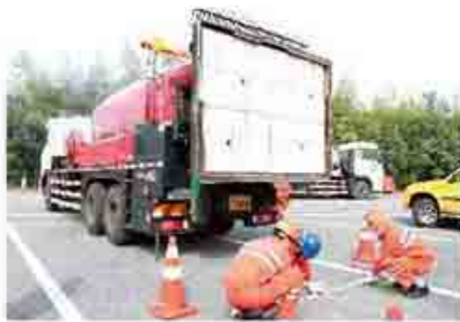
从划定维修范围至维修完成，仅用时30分钟
